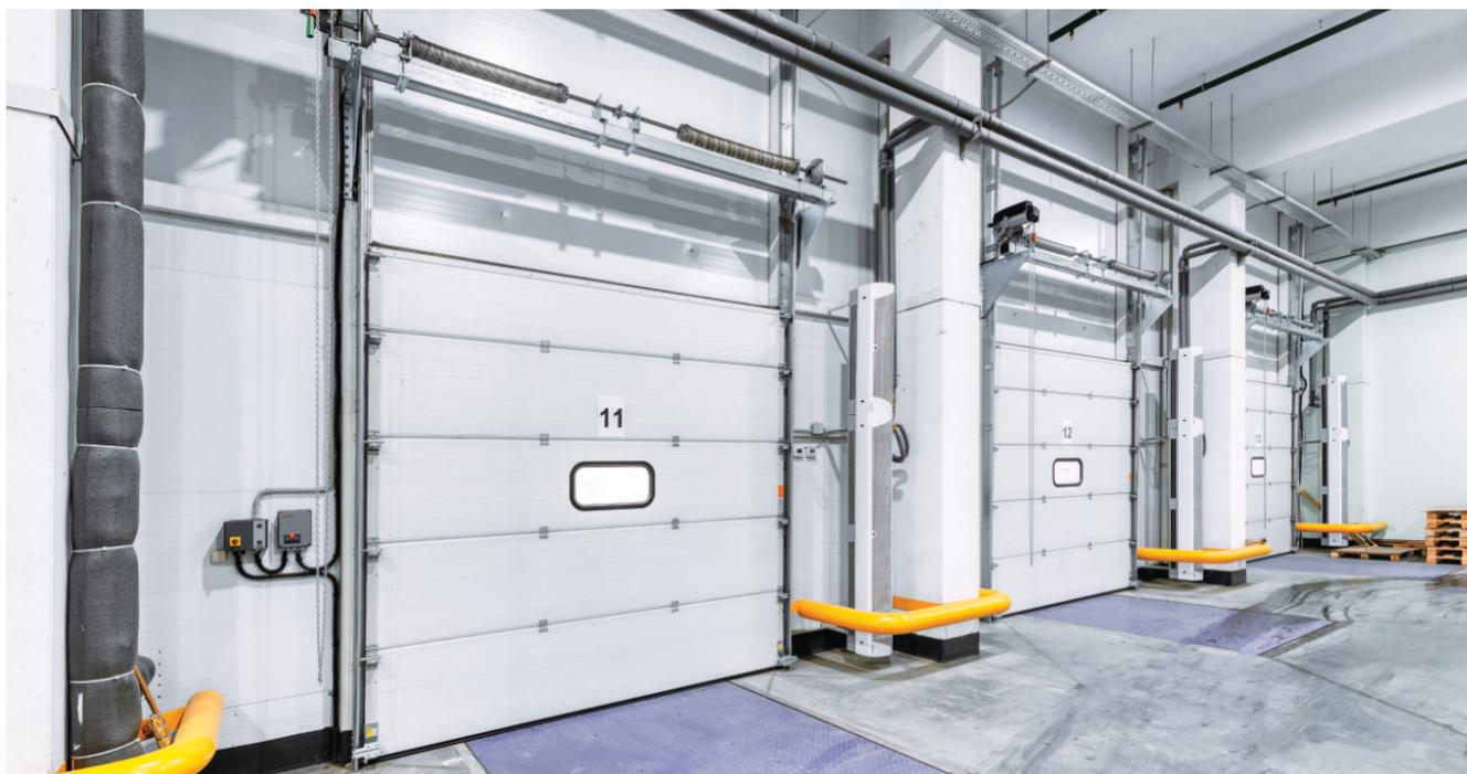
Der Antrieb der GfA-Elektromaten ist auf einer am Sturz befestigten Antriebswelle montiert. Eine seitliche Verriegelung mittels Mikroschalter ist möglich (Zubehörtabelle).
